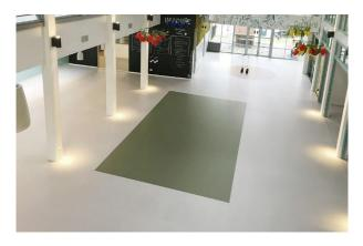
Ndurance ist ein innovativer, fugenloser Kautschuk-Bodenbelag aus rein natürlichem Biopolymer und bis zu 50 Prozent recyceltem Gummi. Zusammen mit natürlichen Farbpigmenten gestaltet dieser die dezente Musterung und Optik des Belags, welcher durch die Verarbeitung ohne unterbrechende Fugen hohen ästhetischen und hygienischen Ansprüchen gerecht wird. Das flexible Material sorgt für ein wohlig weiches Laufgefühl und verliert auch nach langer Zeit seine positiven Eigenschaften nicht.
