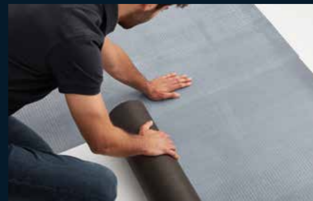
Verlegung FLEX Pro
