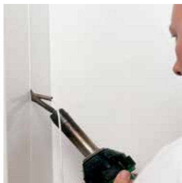
Altro Whiterock Welded joint (Schweißnähte)
