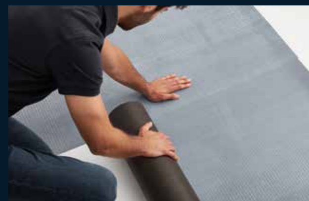
Verlegung FLEX Pro
