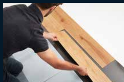
Verlegung der EASY COMFORT UT-DB 1000
